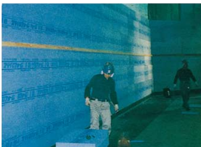
⑤断熱材を設置
