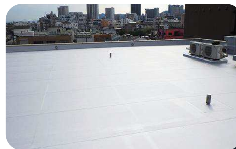
屋上防水 施工例
