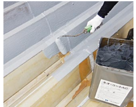
ネオ・コートAG塗布状況
