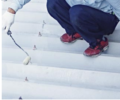
メタルプライマーF塗布状況
