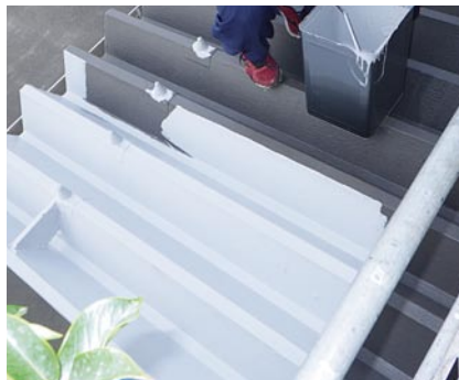
AGトップコート塗布状況
