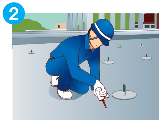
切粉除去・エポキシ注入
