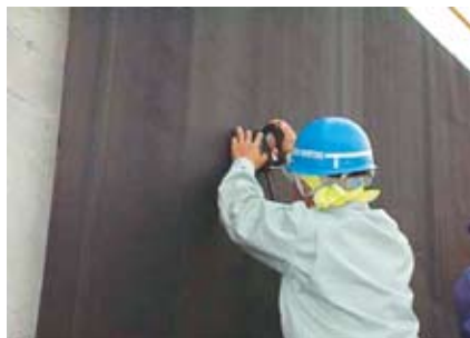
④ 電磁誘導加熱機による溶着
