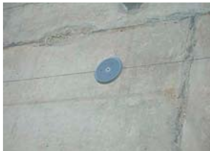
④ 電磁誘導加熱機による溶着
